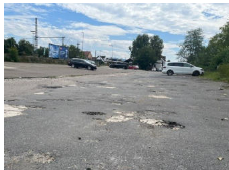
Bahn frei für die Bahnstadt Nürtingen: Auch auf dieser Brachfläche sollen Wohnungen entstehen.
